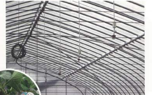
吊り下げ式スプリンクラー
