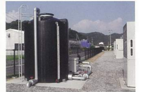
ハウスタンク設置
